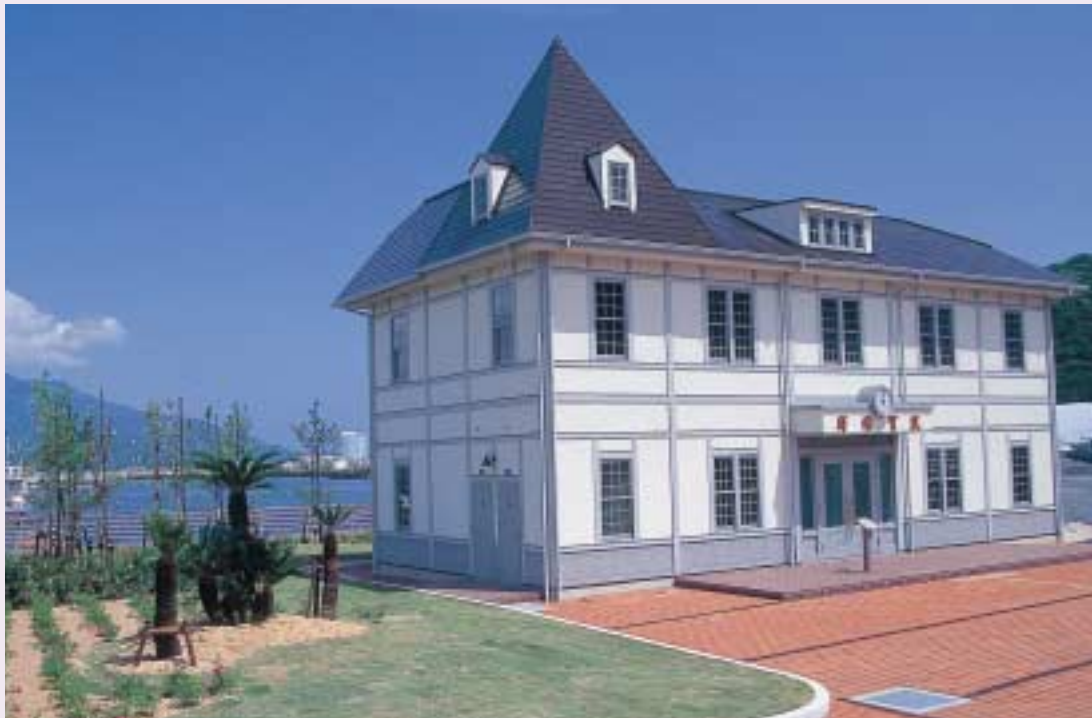
敦賀港駅舎（敦賀市港町）
